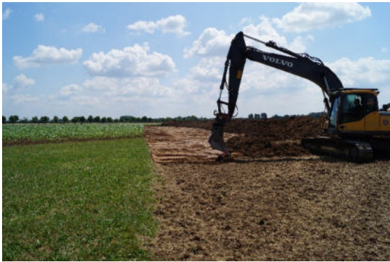
Beginn der Erdarbeiten
